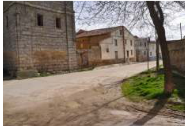
Vista general del entorno de la iglesia en la zona oeste.
