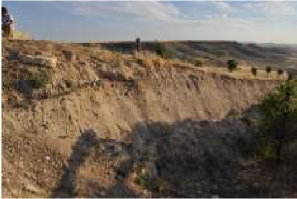
En las obras realizadas para efectuar el "Mirador de Tierra de Campos", se rebajo parcialmente la parcela 5061, lugar en el que, con anterioridad, se localizaron restos óseos. En el corte realizado se observa la existencia de lajas planas calizas que podrían relacionarse con la necrópolis medieval.
