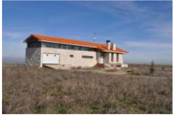
Parcela 40, la cual está en baldío y presenta una vivienda construida recientemente.
