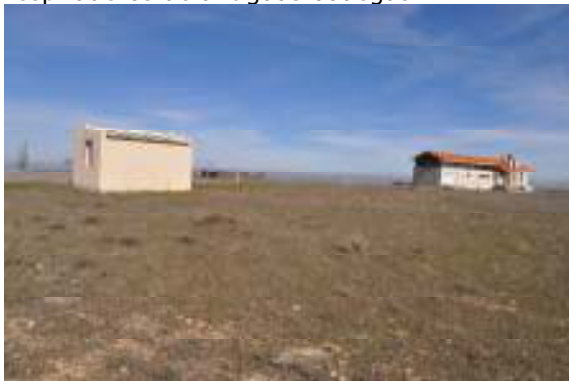
Vista del yacimiento desde la vertiente noroccidental, detalle de las construcciones existentes en esta área.
