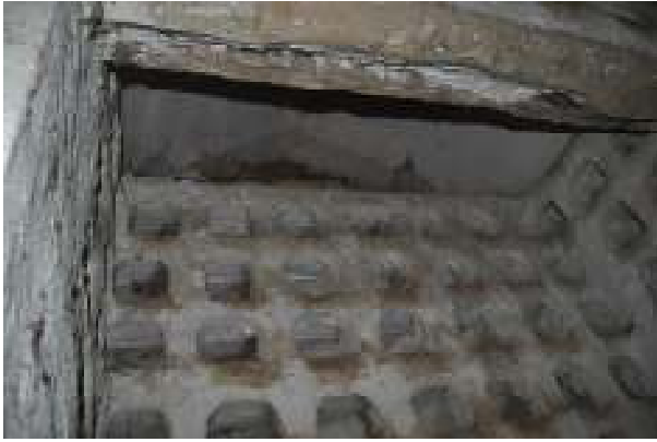
Interior de la ermita, muro adosado a la portada. Detalle de los nidales semicirculares que se empotran en los gruesos muros de tapial que compartimentan el espacio interior. En la parte superior de la fotografía, detalle del arco de medio punto apuntado que enmarca la portada de acceso.
