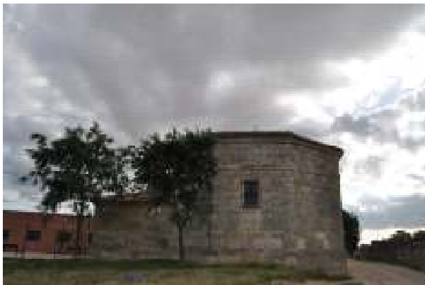
Vista de la cabecera de la ermita. Esta área también está sobre elevada con respecto al camino.
