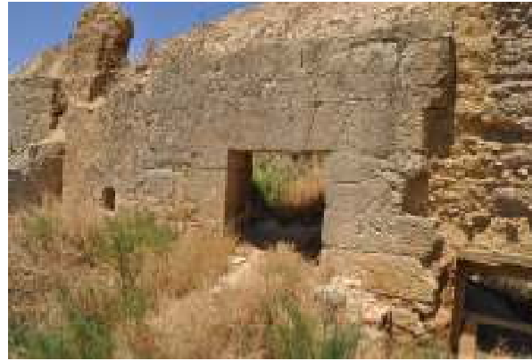
Portada de acceso al palomar de tapial, situado a poniente y construido, adosado a la ermita. Existe un gran contraste entre los materiales utilizados lo que plantea la hipótesis de su reutilización, perteneciendo en origen a otro tipo de edificación.
