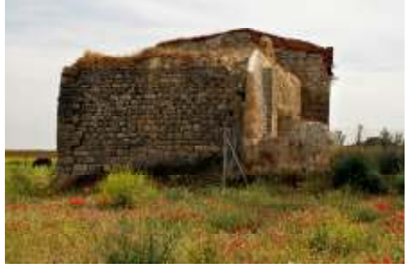
Detalle del lado oeste de la edificación aneja. Fotografía realizada desde el oeste en dirección este.
