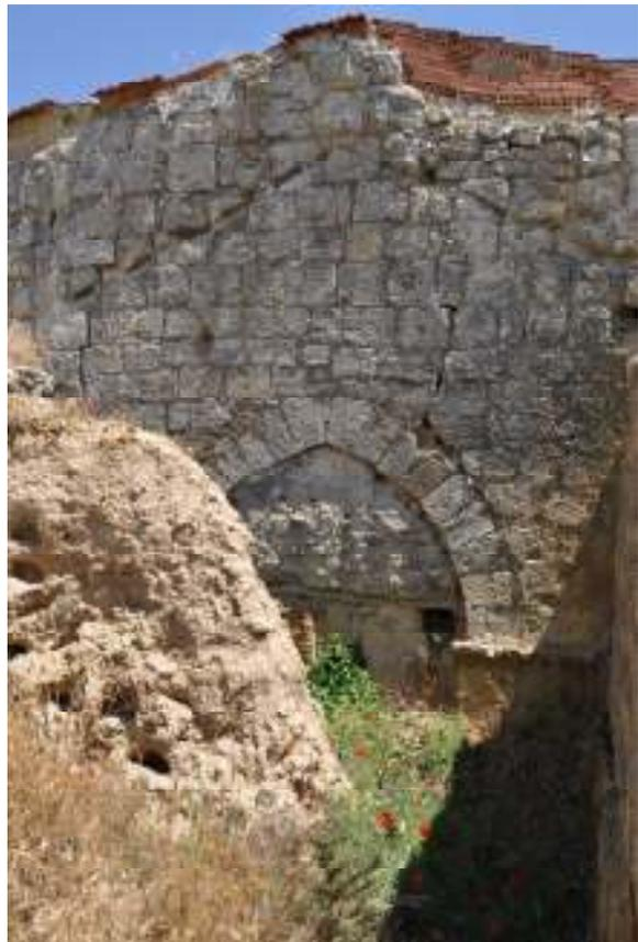
Vista de la fachada de la ermita y de la puerta de entrada, la cual está cegada y se ubica en el interior de la estructura aneja. Obsérvese como queda marcado, en la parte superior de la fachada, el primitivo tejado a dos aguas
